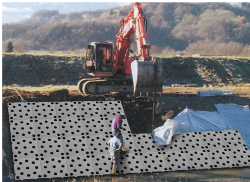
Particolare della posa in opera
