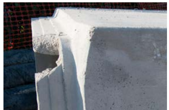
Esempio di giunto non armato
